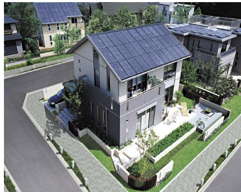
Bild: Fotovoltaik-Anlagen, Japan
